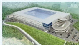
ロジポート福岡粕屋 2024年8月竣工予定
