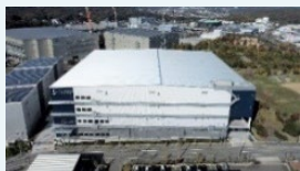
ロジポート神戸西 2021年11月竣工
