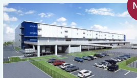
(仮称) 岩塚物流施設 2025年6月竣工予定
